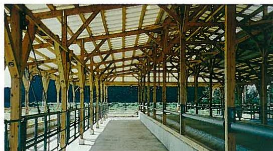
牛舎内部構造(通路幅は2m×40m)
