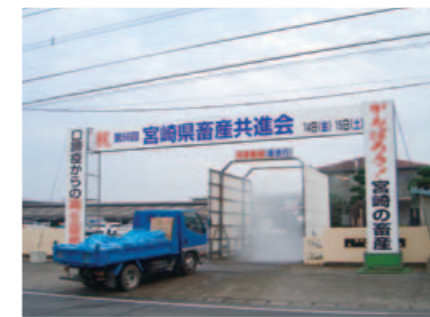
ゲート式車両消毒設備（種畜部門）
