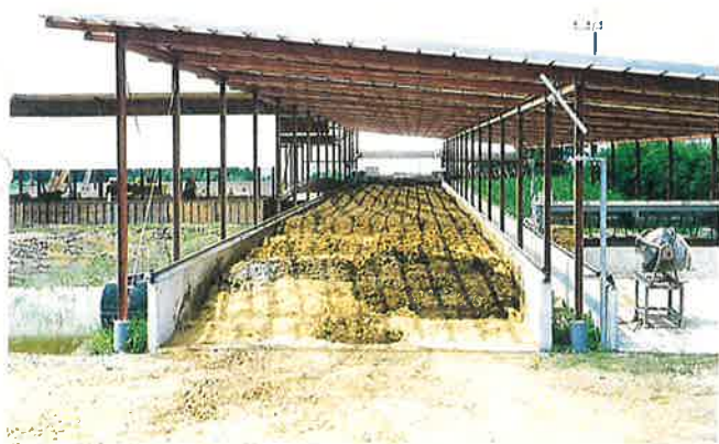
堆肥化施設（機械攪拌方式）
